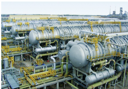
Figura 5. Equipos MED en la industria [4]
